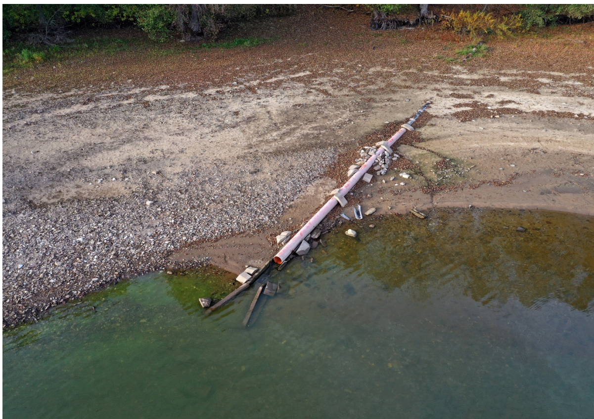
Odhalená výpušť z ČOV na severozápadním cípu Radslavské zátoky.
